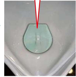
塩酸系トイレクリーナーで表面が荒れた状態
